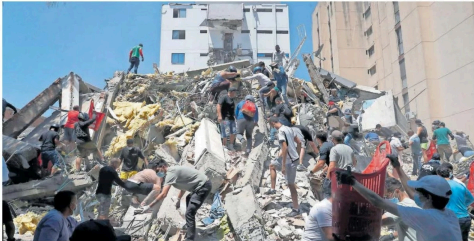
Bomberos y civiles buscaban ayer supervivientes entre los escombros de edificios que colapsaron por el terremoto en Cali. ERNESTO GUZMÁN JR (EFE)
