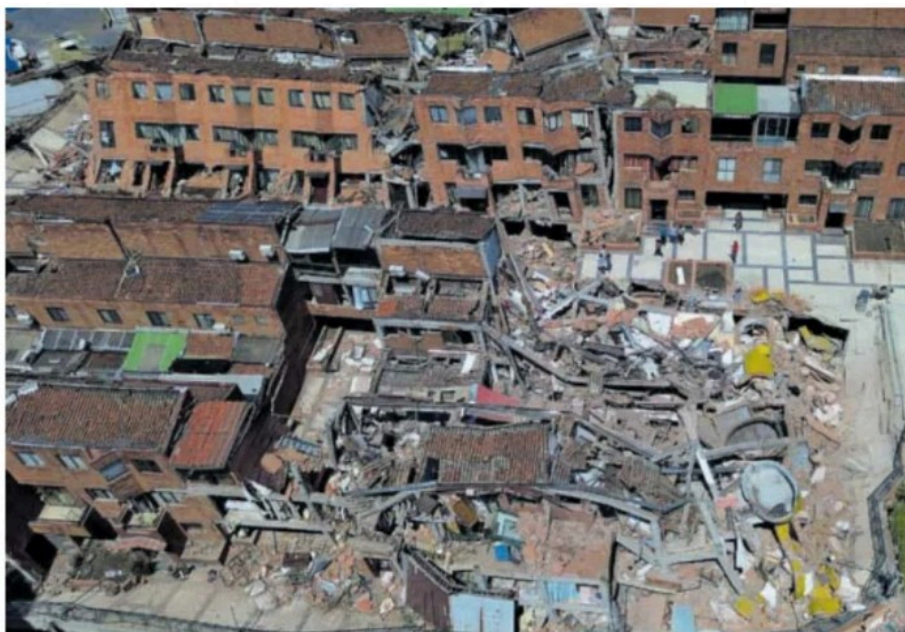
Edificios colapsados ayer en Cali. ALEJANDRO MELÉNDEZ
