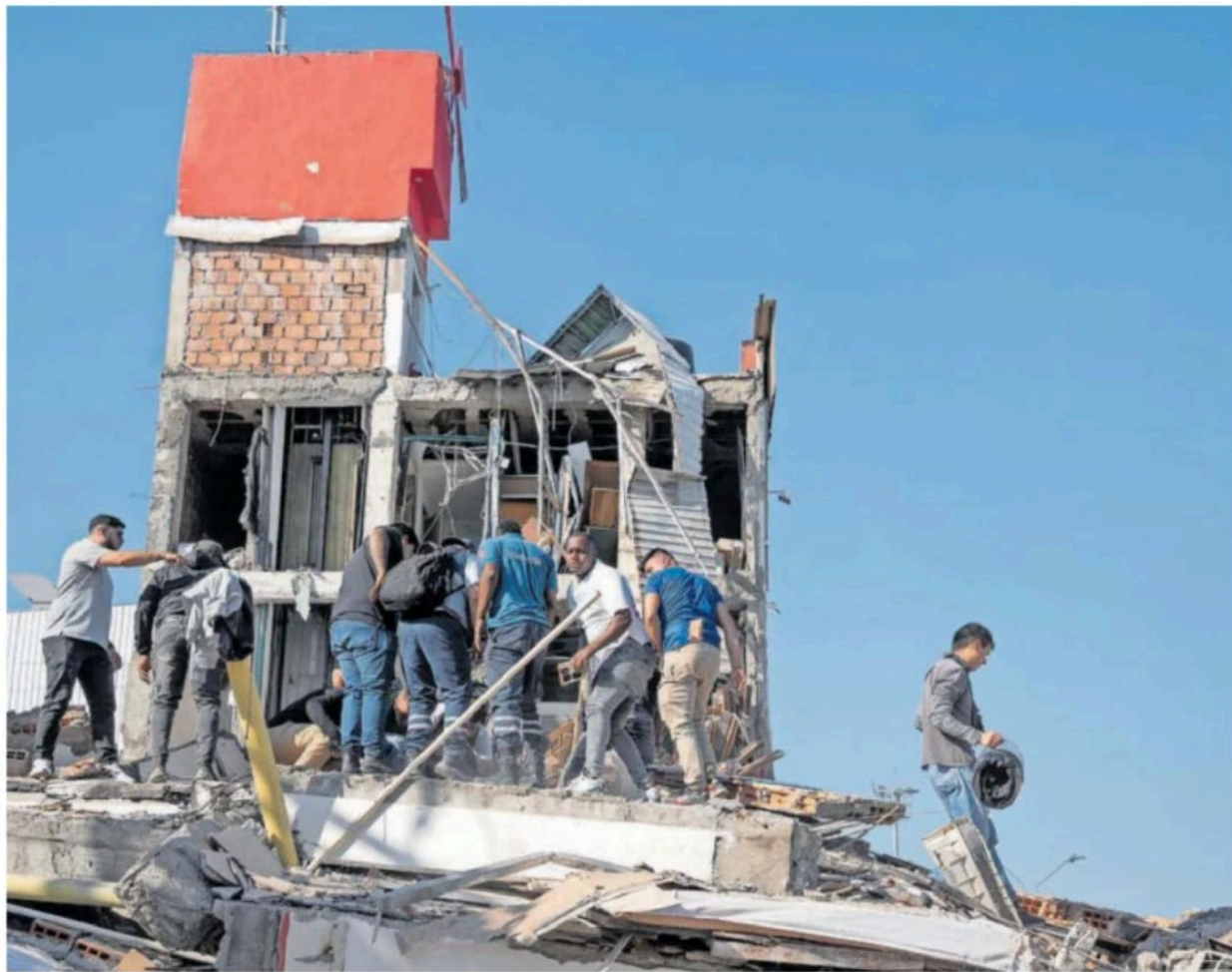
Varias personas buscaban supervivientes en un edificio colapsado ayer por el seísmo en Cali. J. F. C.
